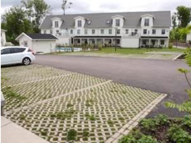
Bild 12. Parkeringsplats med dränerande konstruktion. Foto: Björn Schouenborg, CBI.
