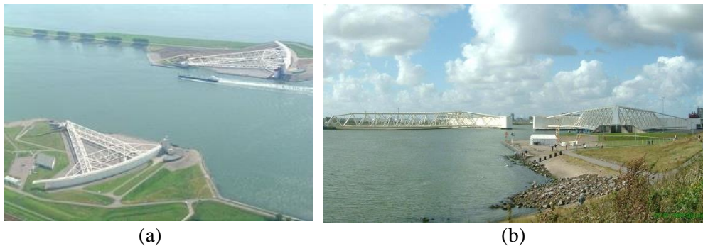
Bild 18. Exempel på barriär: Maeslantbarriären i Hoek van Holland, Nederländerna, som ska skydda Rotterdam och dess omgivningar från översvämningar från Nordsjön. Barriären är världens största rörliga konstruktion och invigdes 1997 efter sex års byggande. Bild (a) visar den i öppet läge och bild (b) när den håller på att stängas. Foto: Eszter Simfoni (a) och Quistnix (b).
