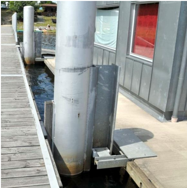
Bild 25. Fastsättning för flytande hus. Foto: Tarrakaner.
