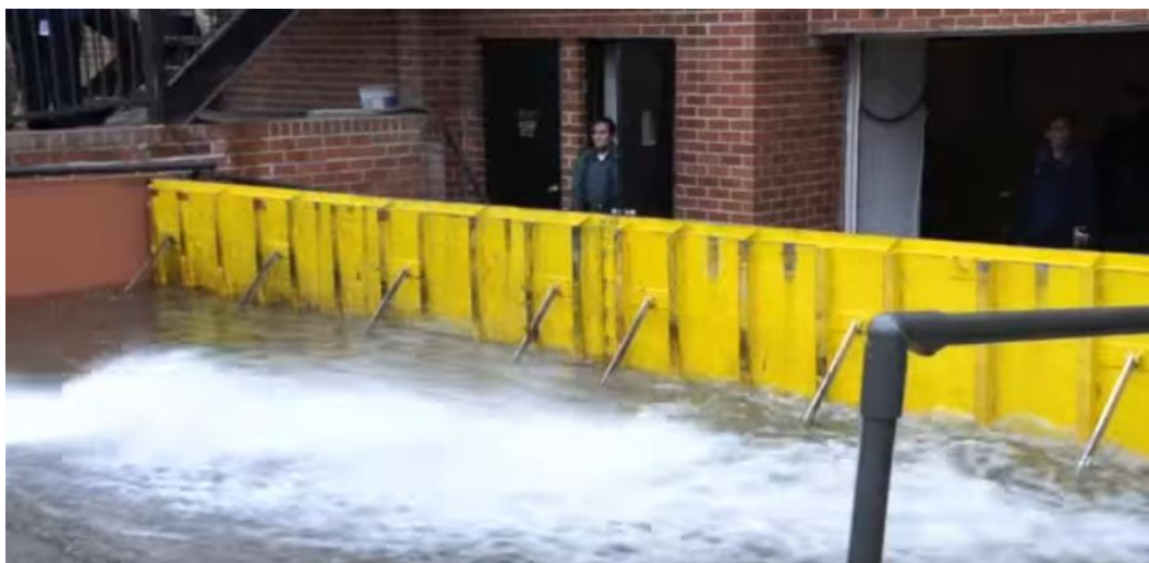
Bild 21. Vatten hindras tränga in i bottenvåningen med hjälp av en konstruktion som fällts upp. Källa: http://floodbreak.com/products/
