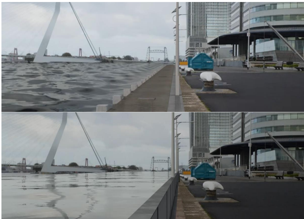
Bild 20. Exempel på självstängande översvämningsskydd. Skyddet höjs i samband med att ett utrymme framför och under skärmen vattenfylls. Se vidare på företagets hemsida. Källa: www.aggeres.com .
