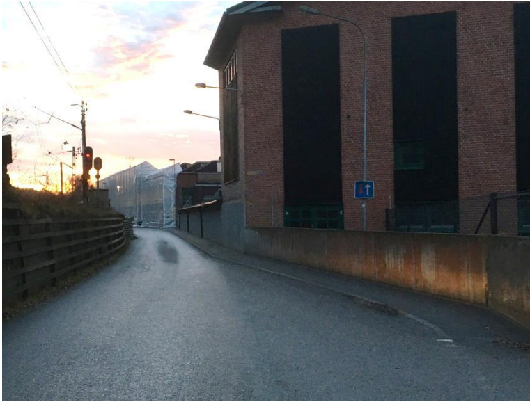
Bild 17. Bilväg i Mölnlycke som är förberedd att vara en vattenkanal vid höga vattenflöden. Foto: Eva Sikander.
