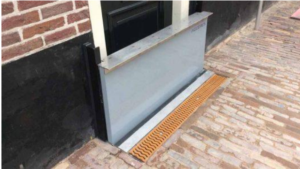
Bild 26. Exempel på lösning för att hindra vatteninträngning. Luckan är i detta fall nedfärd i marken och lyfts upp då installationen vattenfylls – anges såsom självstängande. Källa: www.aggeres.com
