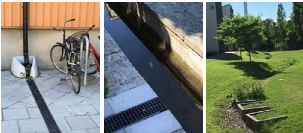
Bild 14. Regnvatten från taktytor och gator leds in i öppna dagvattenkanaler i Malmö som kommer i bruk i samband med regn. Foto: Eva Sikander.
